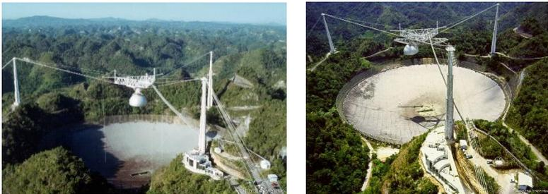
アレシボ天文台の 305m 電波望遠鏡の空撮写真。3 基のタワーからケーブルが伸び、中央部分で受信機などを取り付けたプラットフォームが吊られている (C) Arecibo Observatory
