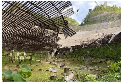
2020年11月7日に撮影されたアレンボ天文台の305m電波望遠鏡。お皿のような形の反射面部分に穴が空いている様子がわかる (C) University of Central Florida
