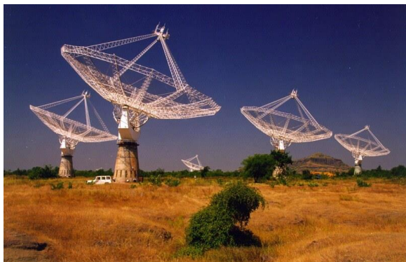
【▲ 図 1: インドのプネーにある巨大メートル波電波望遠鏡は、21cm 線やそれより長い波長の電波を観測対象としている。観測対象の電波の性質から、滑らかな反射面を持たずとも骨組みの間に張られたワイヤーで電波を受信できるため、独特の外観を持つ。(Image Credit: Giant Metrewave Radio Telescope / Tata Institute of Fundamental Research / National Centre for Radio Astrophysics)】
