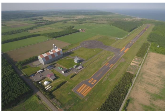
滑走路延伸工事を完了した HOSPO (出所:HOSPO)
